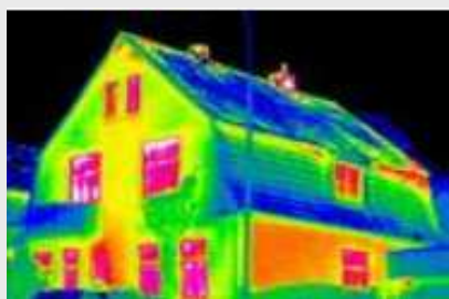
Thermographie d'une habitation
